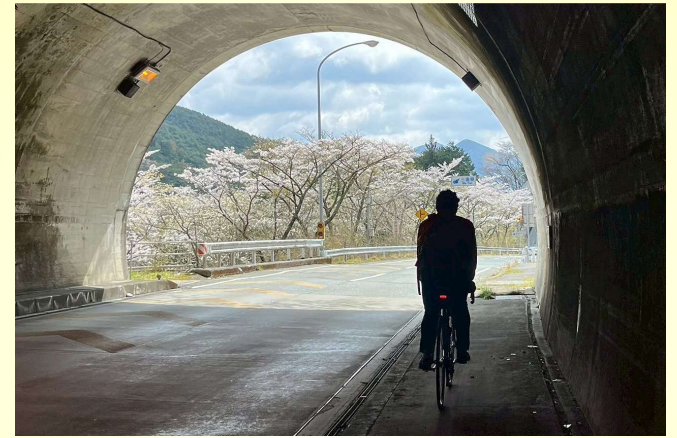
三重県松阪市飯高町木柵 高見トンネル
